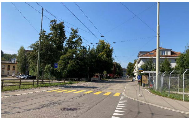
Abbildung 11: Zeughausstrasse, nördlich Mattenbachstr. Der Fussgängerstreifen ist Teil des Schulwegs zwischen dem Primarschulhaus / Kindergarten Schönengrund und dem Quartier Breite. Bei haltenden Bussen in Fahrtrichtung Stadt besteht für querende Personen / Kinder keine freie Sicht auf den Verkehr nach rechts. Eine Schutzinsel, welche die Querung in zwei Etappen teilt, fehlt.
