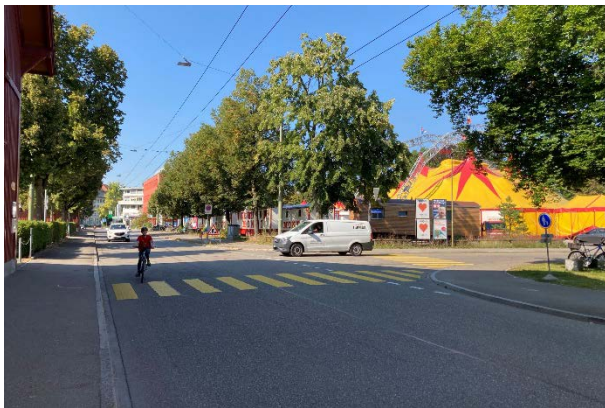
Abbildung 9: Knoten Zeughaus-/Obermühlestrasse Fussgängerstreifen mit unzulässiger Querungsbreite (ca. 11 m).
