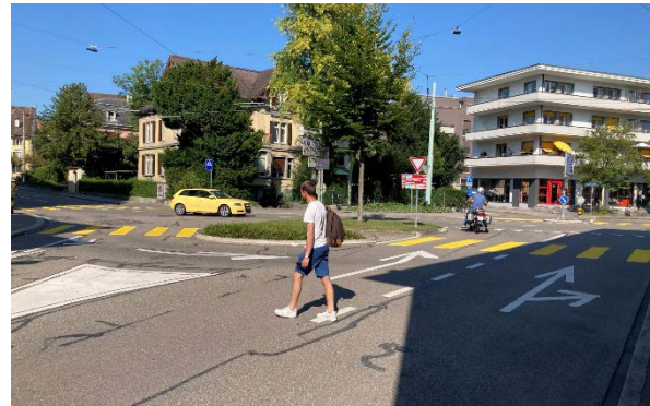
Abbildung 4: Knoten Zeughaus-/Mühlestrasse Aufgeweiteter 5-armiger Knoten mit eingeschränkter verständlicher Verkehrsführung; teils nicht normkonforme Fussgängerstreifen über 2 Fahrstreifen gleicher Richtung oder ohne Mittelinsel bei > 3'000 Mfz/Tag; Fussgängerquerungen finden auf der Ideallinie ausserhalb der Fussgängerstreifen statt.
