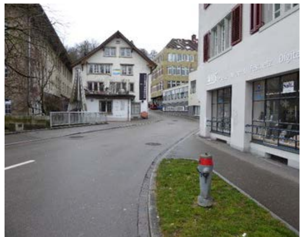
Abbildung 3: Knoten Technikum-/Turmhaldenstrasse, Die Bar „Das schmale Handtuch“ mit kleinem Vorplatz. Ausgeprägte S-Kurve aufgrund der Bebauung. Die Gesamtsituation der Strasse ist als schützenswertes Ortsbild klassifiziert. Die Turmhaldenstrasse ist in diesem Bereich mit «generell 50» signalisiert.
