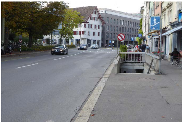
Abbildung 9: Technikumstrasse, Fussgängerunterführung Die wenig einladende Fussgängerführung führt dazu, dass häufig oberirdisch flächig und damit ungeschützt zwischen Turmhaldenstrasse und Holderplatz gequert wird. Die Unterführung beansprucht viel Platz im Seitenraum. Sie wird mit dem BGK aufgehoben.
