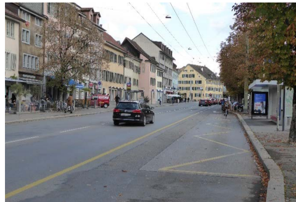
Abbildung 10: Technikumstrasse, Höhe Technikum Ab der Bushaltestelle Technikum in Richtung Holderplatz fehlt ein Velostreifen.
