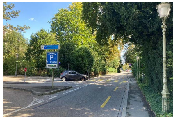
Abbildung 8: Museumstrasse, PH Theater Winterthur Der Fussgängerstreifen führt an der Sträulistrasse über einen kurzen zweistreifigen Strassenabschnitt. Dieser dient der Verflechtung der Nebenzufahrt Sträulistrasse / Parkhaus Theater mit der Museumstrasse. Grosse Querungsbreite und mangelnde Sicht bei Zweistreifigkeit sind nicht normkonform und gefährden Fussgänger.
