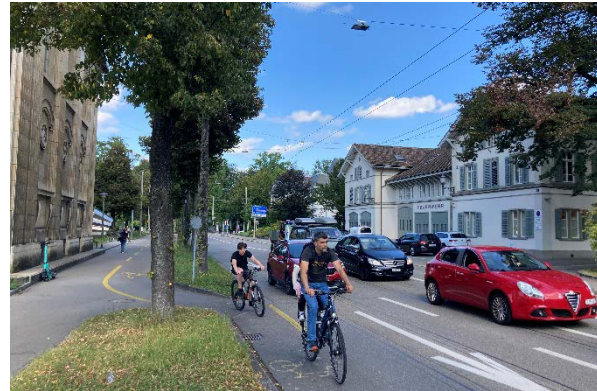
Abbildung 16: Lindstrasse, Richtung St.-Georgen-Strasse Veloverflechtung Ende Radweg / Beginn Velostreifen Lindstrasse. Ein Überqueren der Fahrbahn auf den links-abbiegenden Fahrstreifen Richtung Museumstrasse ist aufgrund der kurzen Verflechtungslänge kaum / nicht möglich.
