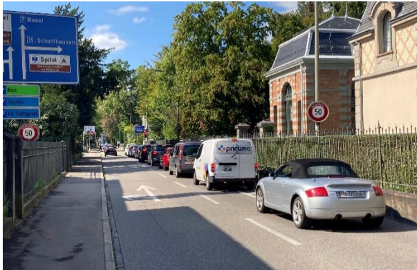
Abbildung 21: St.-Georgen-Strasse, westlich Trollstrasse Die St.-Georgen-Strasse weist für eine HVS sehr schmale Fahrstreifenbreiten für den massgebenden Begegnungsfall Überholen LW/LW auf. Ein Sicherheitsabstand zu den rechts gelegenen Grundstücken ist nicht vorhanden. Ein sicheres Heraustreten von den Grundstücken auf die Strasse ist auch aufgrund der Verkehrsdichte nicht möglich.
