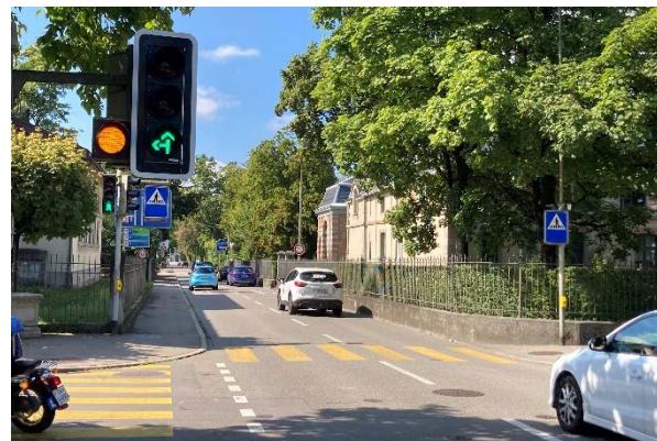
Abbildung 20: St.-Georgen-Strasse, Höhe Trollstrasse Gestreckte Linienführung, grosse optische Breite, freie Durchsicht und zwei Fahrstreifen begünstigen schnelles Fahren.
