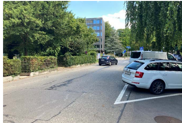
Abbildung 18: Museumstrasse, Höhe Trollstrasse Die Schrägparkierung erfordert Rückwärtsfahrmanöver bei eingeschränkten Sichtverhältnissen.
