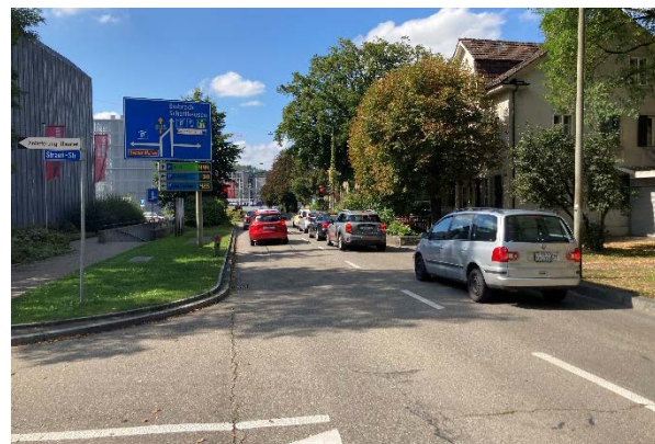
Abbildung 24: St.-Georgen-Strasse, Höhe Sträulistrasse Einengung der durchgehenden Fahrbahn auf einen Fahrstreifen. Die Liegenschaft Nr. 86 mit Garage (rechts) erfordert Rückwärtsfahrmanöver auf die HVS. Wenden auf dem Grundstück ist nicht möglich.
