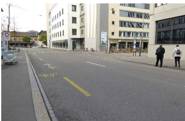
Abbildung 9: Lagerhausstrasse, zwischen Archstrasse und Meisenstrasse Grosszügiger Querschnitt mit Velostreifen und Mittelstreifen; Fussgängerstreifen an Archstrasse ohne Schutzinsel; Fussgänger queren hier mehrheitlich flächig.
