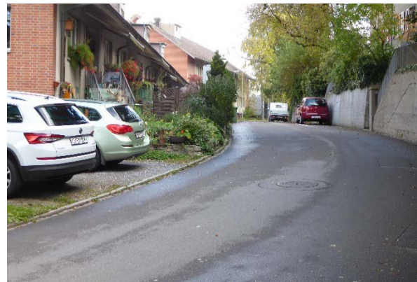
Abbildung 4: Frobergstrasse Die Frobergstrasse ist eine Erschliessungstrasse mit engen Verhältnissen: Unmittelbar angrenzende Grundstücke / fehlendes Trottoir, kleine Kurvenradien und Parkierung im Strassenraum.
