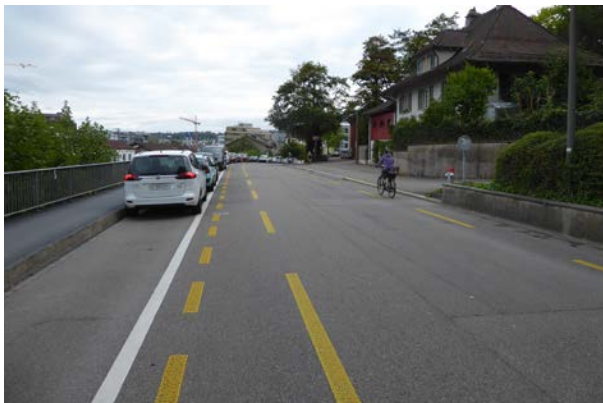
Abbildung 3: Untere Vogelsangstrasse, Höhe Frobergstr. Abschnitt mit klarer Verkehrstrennung; Für Velofahrende bestehen Konflikte bei verdeckten Zufahrten (rechts im Bild) resp. mit der Längsparkierung (links im Bild). Der hohe Randstein (links) ist eine Gefahr sowohl für Fussgänger (Sturz) wie Fahrzeuge (fehlende Bodenfreiheit).
