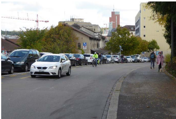
Abbildung 5: Untere Vogelsangstrasse, Höhe Salzhaus Ab der Frohbergstrasse ist der Velostreifen in Richtung Stadt im Bereich mit spürbarem Längsgefälle aufgehoben.
