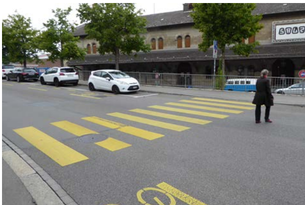
Abbildung 7: Untere Vogelsangstrasse, Höhe Salzhaus Am Salzhaus befindet sich ein Fussgängerstreifen ohne Schutzinsel und leicht versetzt zur Wunschlinie. Fussgänger queren daher meist in direkter Linie.
